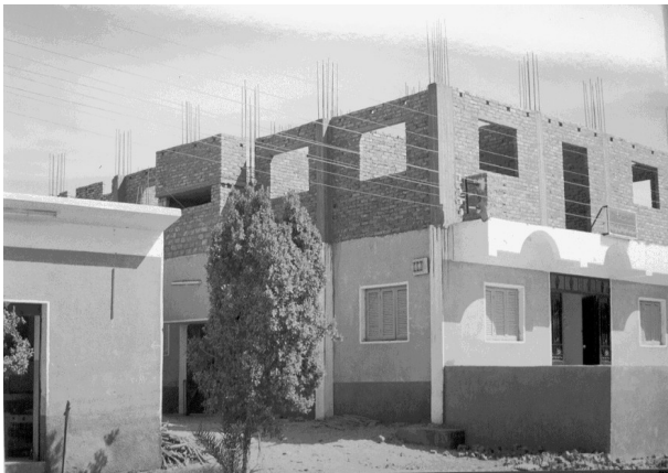
De bouw vordert gestaag !
